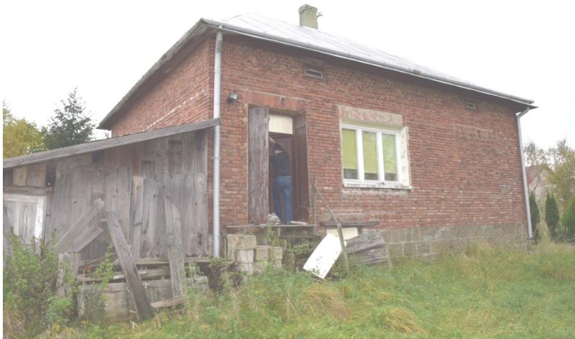
Budynek widziany z innego ujęcia.
