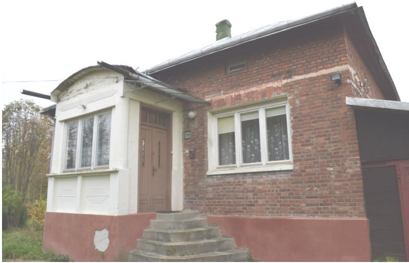
Widok budynku mieszkalnego z różnych ujęć
